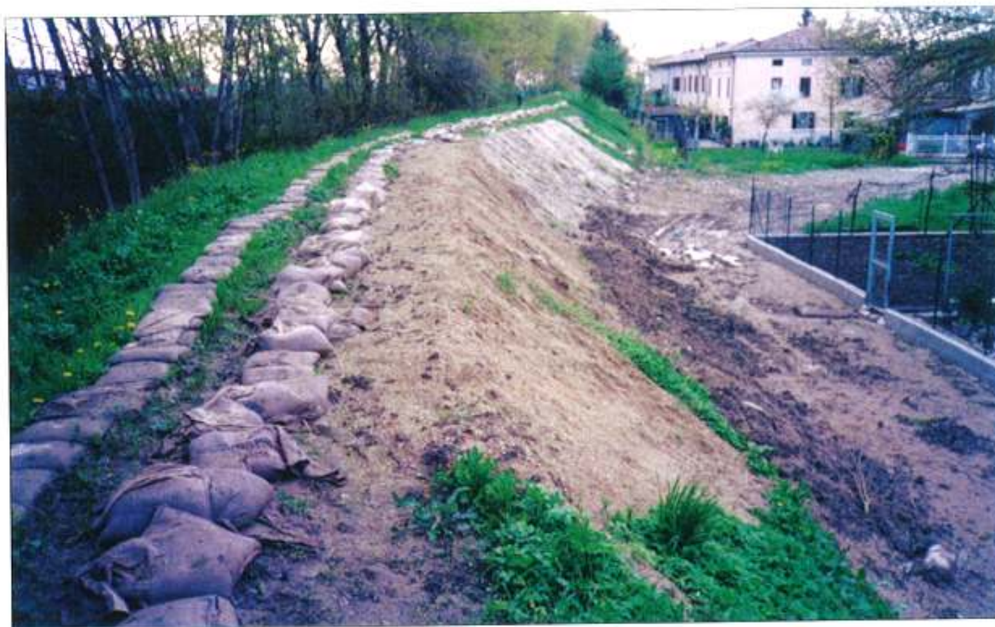
Fig. 1.36: rinfianco arginale con sabbia sul torrente Lorno a Colorno (Parma) per controllare la maggiore spinta dovuta al rigurgito del fiume Po durante la piena del 2000.
