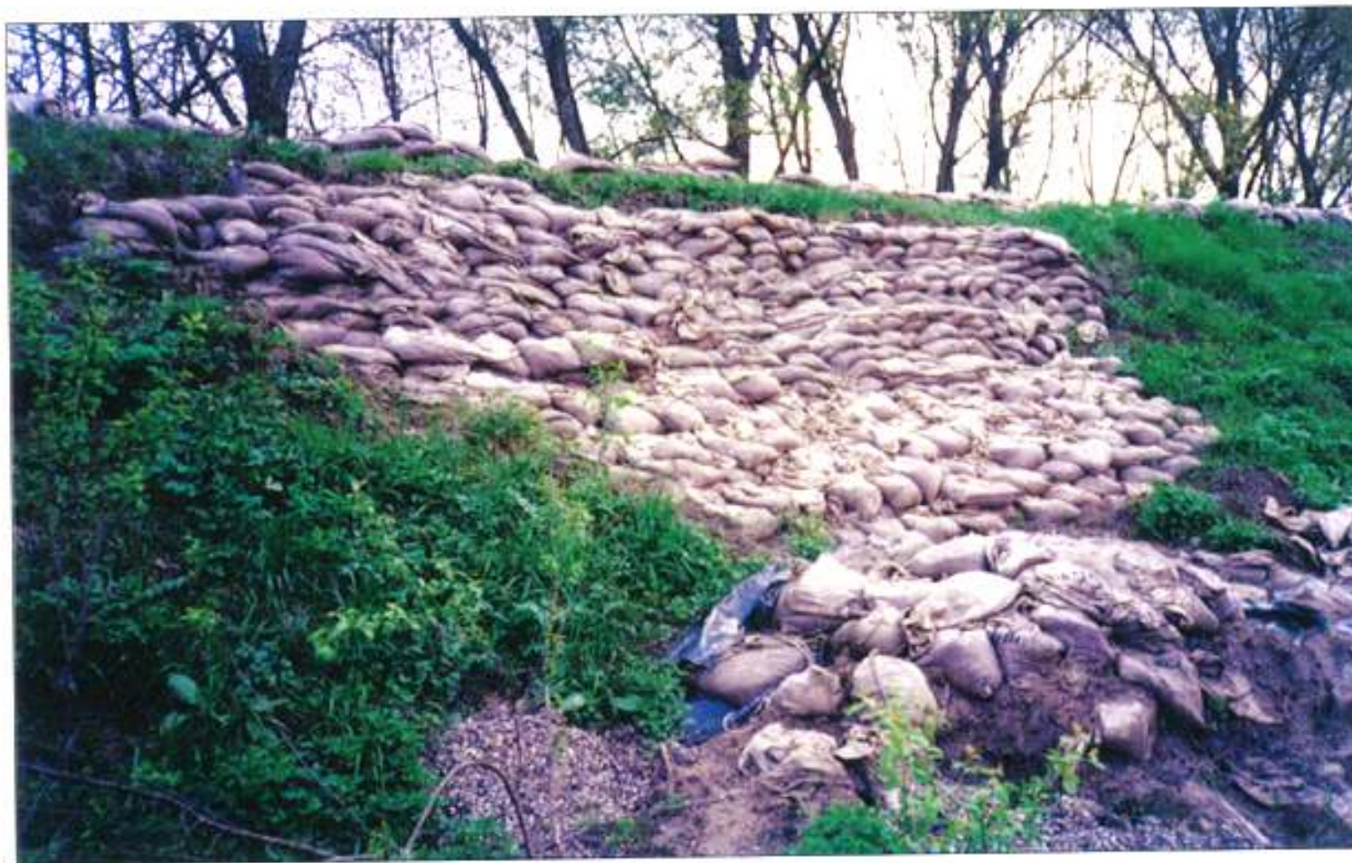
Fig. I.37: rinflanco arginale con sabbia sul torrente Lorno a Colorno (Parma) per controllare la maggiore spinta dovuta al rigurgito del fiume Po durante la piena del 2000.
